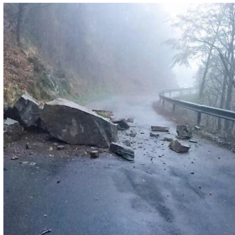
I massi che si sono staccati dal versante e sono precipitati sulla strada per Tagliole
